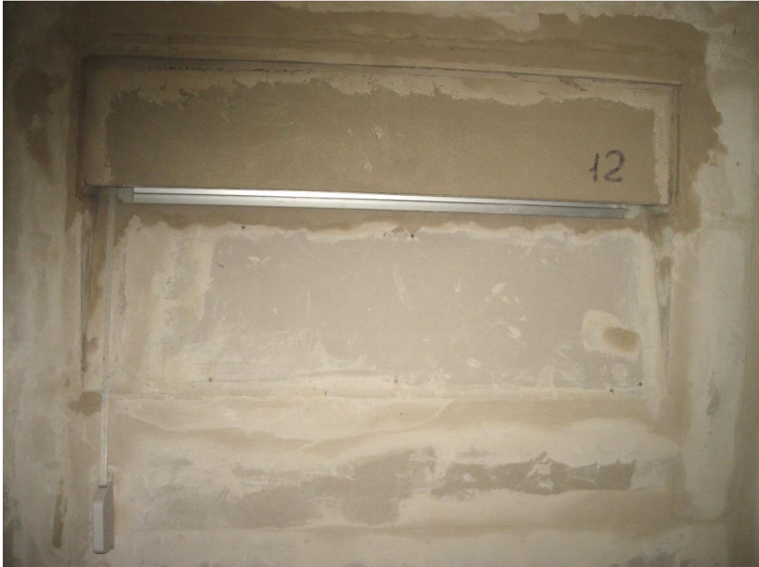
Bild 5: ROKA - TOP 2 RG 28/25, Senderraum (Messung 4)
