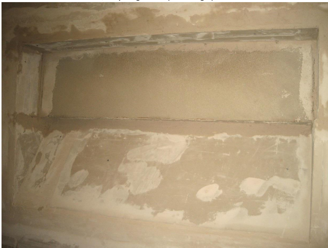
Bild 7: ROKA - TOP 2 RG 30/30, Empfangsraum (Messung 5)
