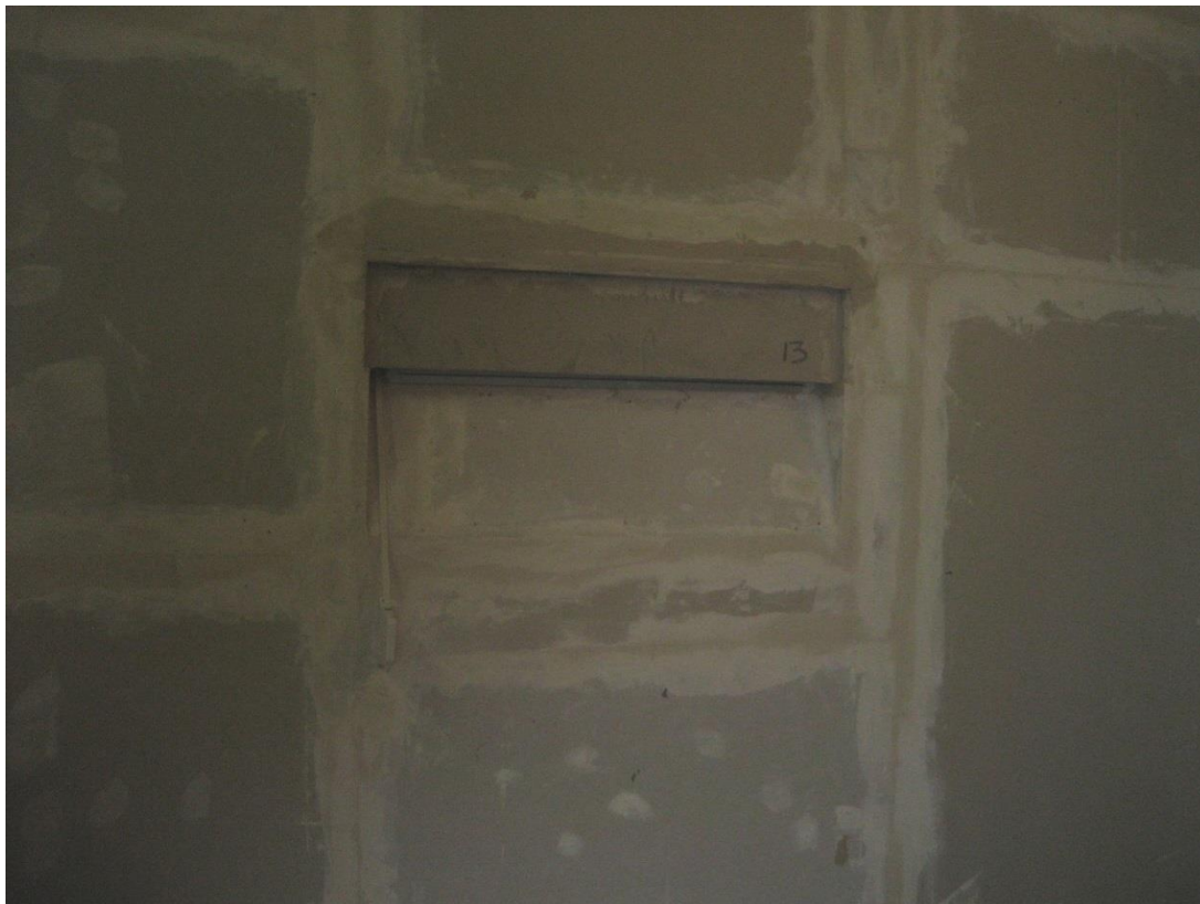
Bild 1: ROKA - TOP 2 28/25, Senderraum (Messung 1)
