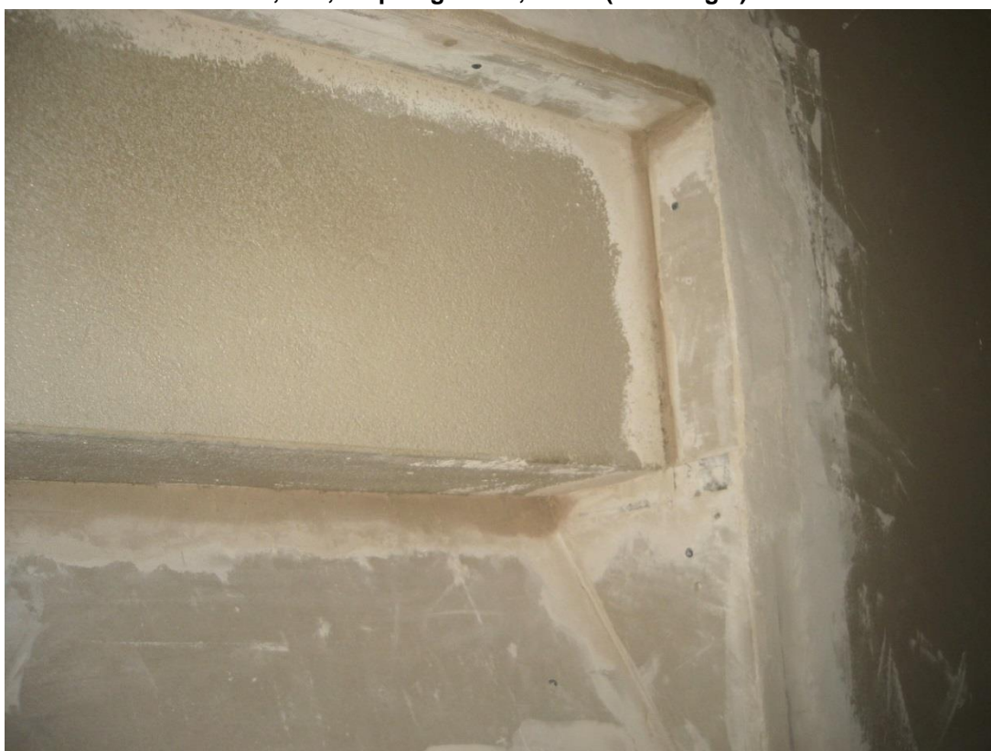
Bild 8: ROKA - TOP 2 RG 36,5/30, Empfangsraum, Detail (Messung 6)
