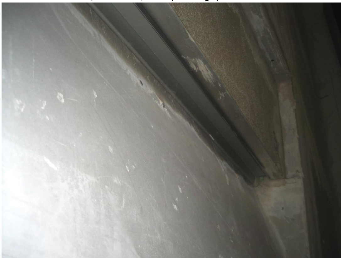
Bild 2: ROKA - TOP 2 30/30, Senderraum, Detail (Messung 2)
