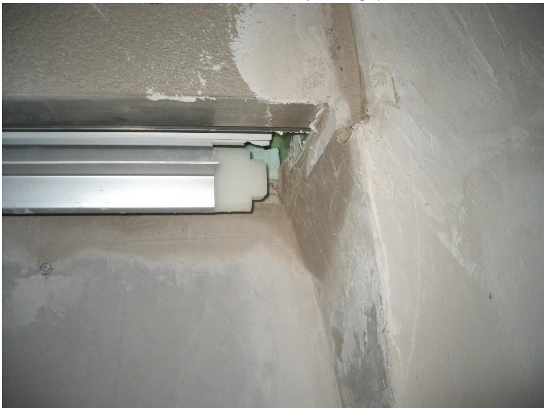
Bild 6: ROKA - TOP 2 RG 36,5/30, Senderraum, Detail (Messung 6)
