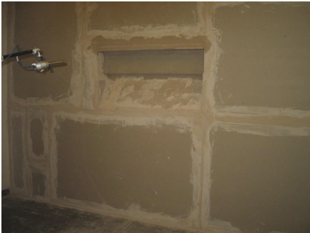
Bild 3: ROKA - TOP 2 28/25, Empfangsraum (Messung 1)
